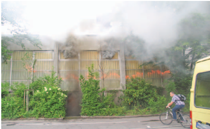
Lage vor Eintreffen der Feuerwehr: Flammenzungen, Rauch- und Pyrolysegase haben die ganze Halle erfasst.
