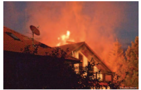
Nach dem Flashover.
