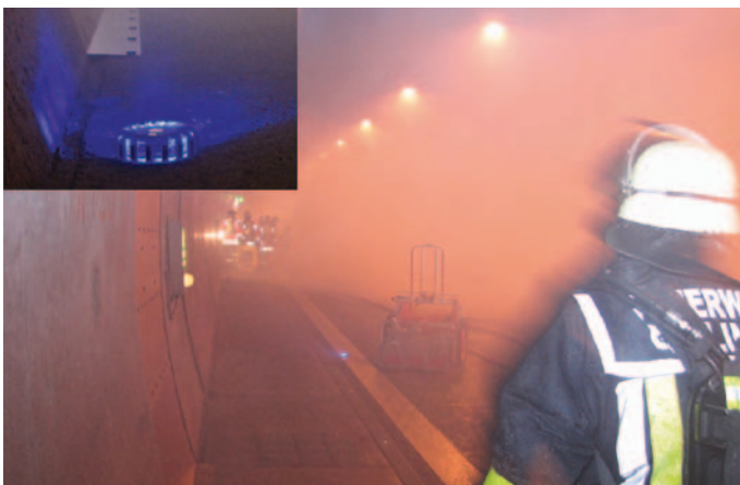
Blaue LED-Blinkleuchten markieren die Lage der Verteiler und der Wasserentnahme.
