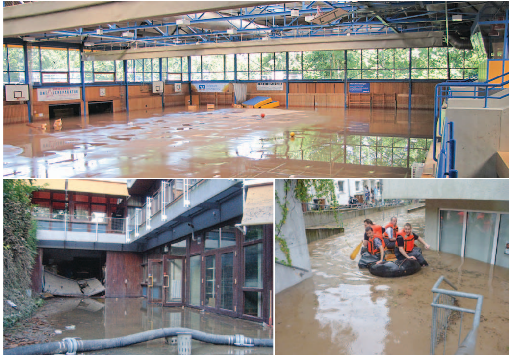
Oben: In der Sporthalle Glemsaue schwammen Hallenboden und Sportgeräte im 1,5 Meter hohen Schmutzwasser.
