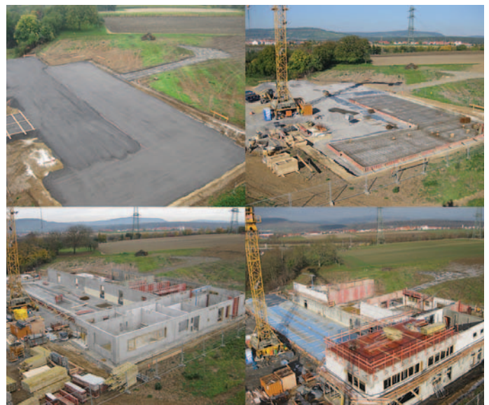
Baufortschritt der neuen Feuerwache in Vaihingen.
