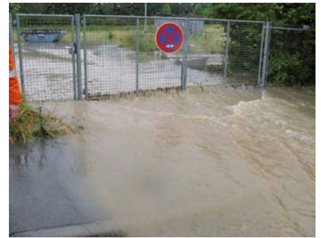
Regenüberlaufbecken Lingwiesenstraße in Münchingen.
