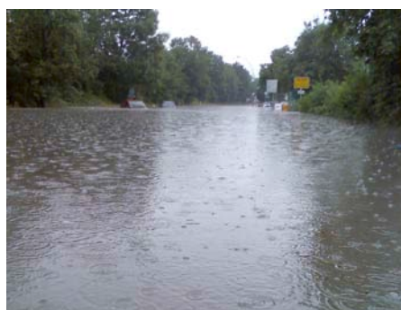
Regenüberlaufbecken Talstraße in Korntal.
