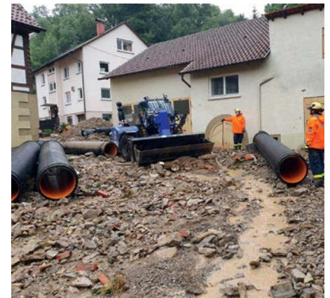
Zum Teil standen Schlamm und Geröll bis zu 1,40 Meter hoch.
