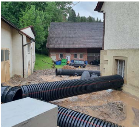
Schlamm- und Geröllmassen an der Mühle Wolfsölden.
