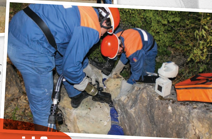
Befreiung einer „verschütteten Person“.
